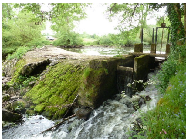
Illustration 1 : Le barrage est dégradé. En amont du barrage, la Grande Maine se comporte comme un étang avec une eau profonde, calme et stagnante.
